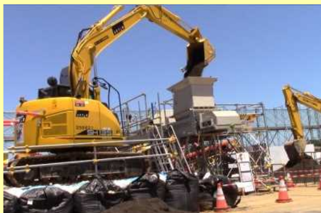
ホッパーへの除去土壌投入
