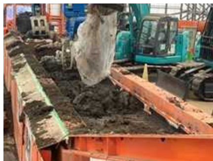
破袋後の土壌の取り出し
