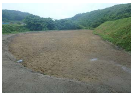
仕上がり状況(直後)
