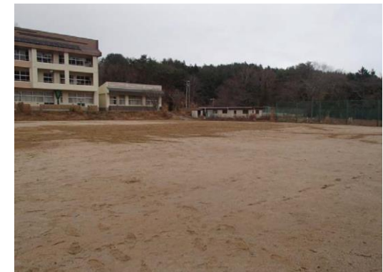
仕上がり状況
