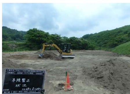
均平化(不陸整形)
