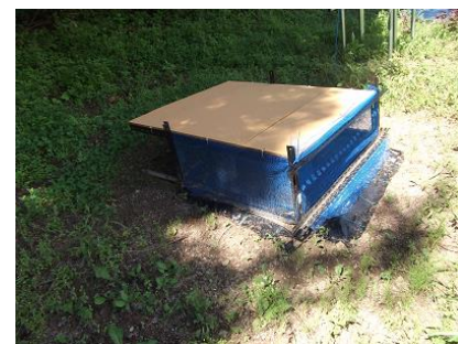
図3 ネットフェンスの設置状況
