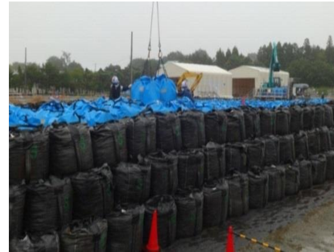
保管場への定置作業
