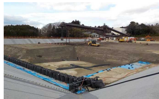
土壌貯蔵施設(双葉1期①工区)
