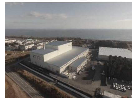
大熊町の仮設焼却施設
