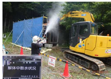
被災家屋等の解体の様子
