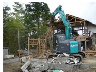
被災家屋等の解体
