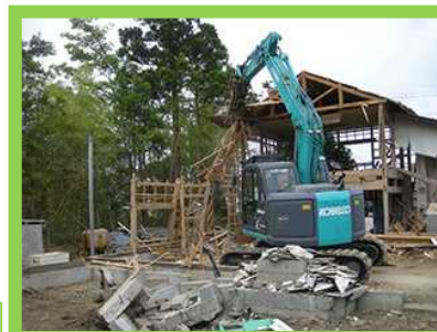
被災家屋等の解体
