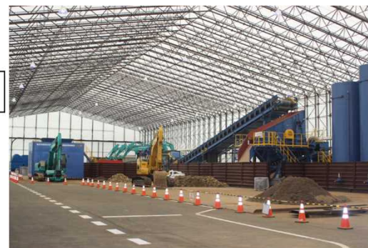
受入・分別施設(大熊1期②工区)
