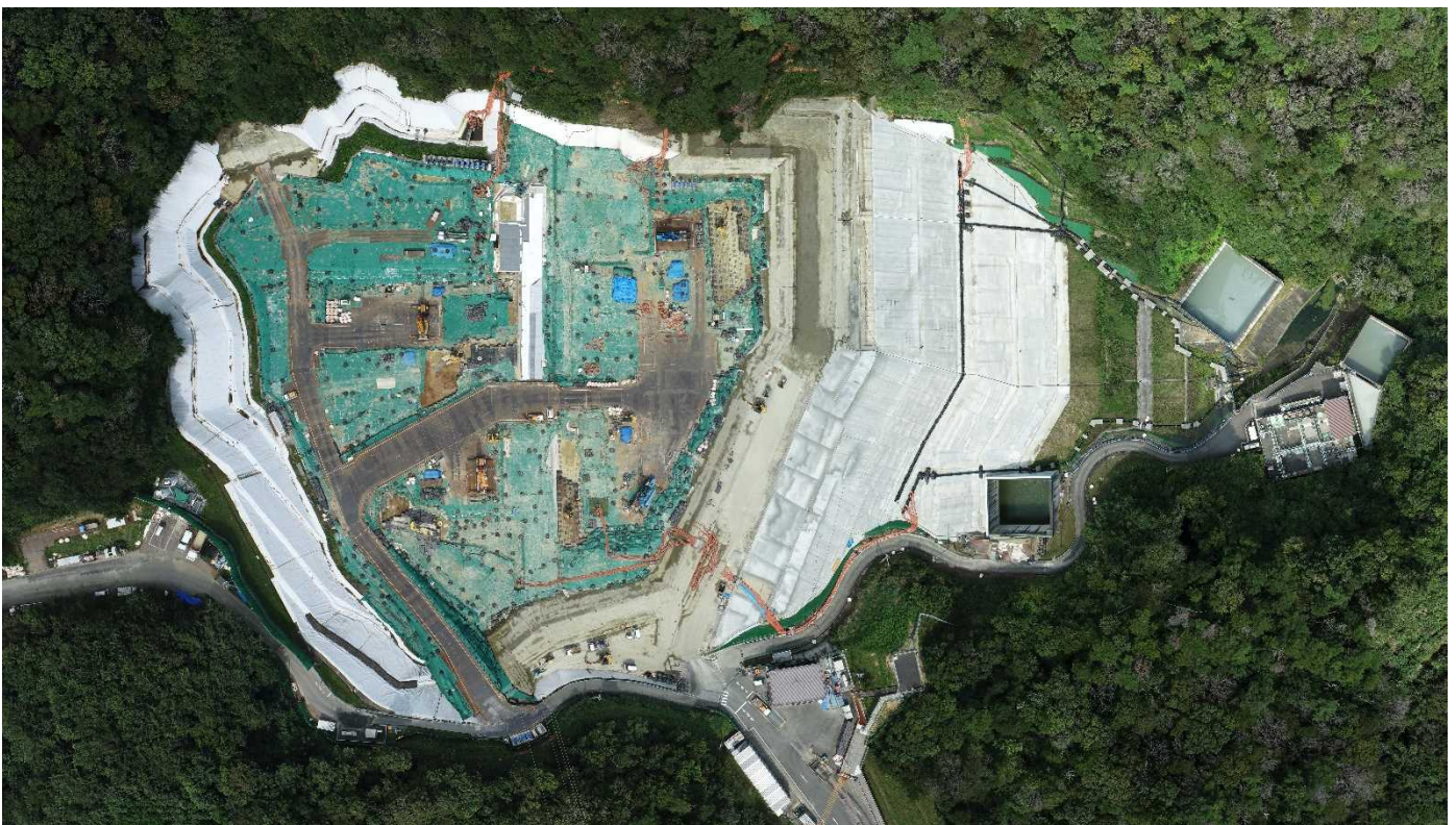
特定廃棄物埋立処分施設 （2021年9月15日撮影）
